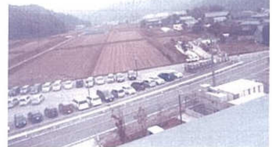
(工事前 駐車スペース52台分)
