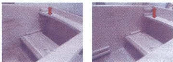
7cmの差をつけることで、安定した座位まで着く事ができた
