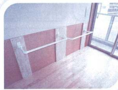
立ち上がり訓練用の手すり
